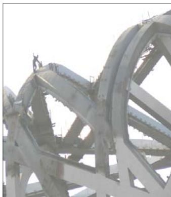
Pékin olympique : le stade « nid d'oiseau » en construction, jour et nuit
