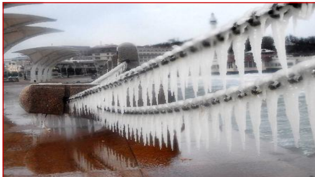
Une vague de froid, plus vue en 56 ans, frappa la Chine du Nord, les 4-5 mars. Ici, le chantier naval de Yantai (Shandong)
